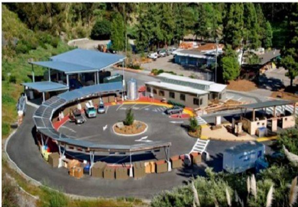
Εικόνα 2 : ΠΣ με πλατεία για την εκφόρτωση και περιμετρική οδό για τη διαχείριση / μεταφορά των υλικών
